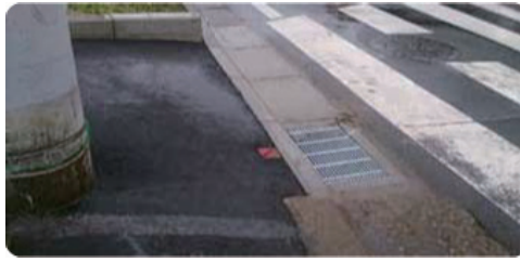
②交差点に隣接する複合商業施設南西角地の歩道の拡幅と電柱の移設。
