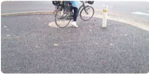
①あたご橋下の歩道の段差解消と勾配改善の実施。
