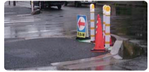
③マラソン道路と日立製作所前通りに挟まれた歩道部の平坦性確保と車止め等の安全対策。
